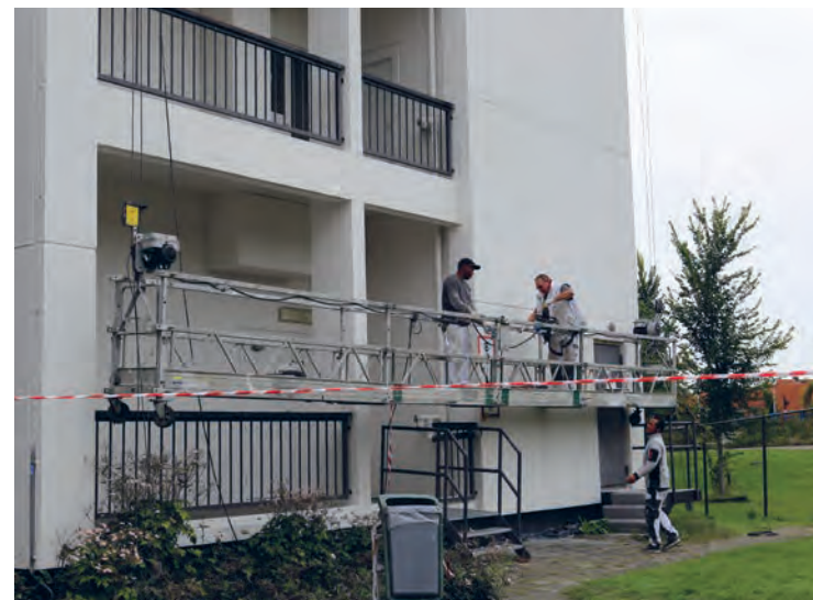
Het gros van de gevels kan vanuit een hangbak worden geschilderd
