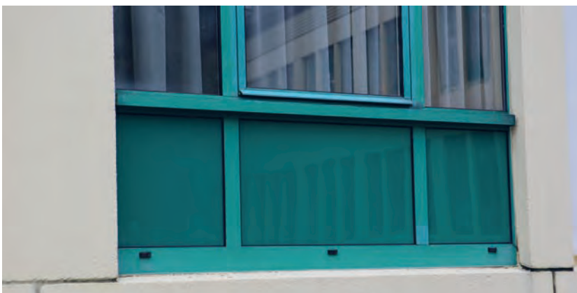
Groen gecoate glaspanelen worden voorbehandeld met een zK epoxyhars-hechtprimer
